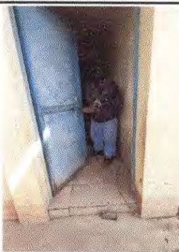
Foto 2: Instalación de chapa de la puerta del modulo 3
