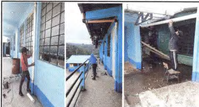
Foto 8: Instalación de baja de agua pluvial tubo PVC 3"
