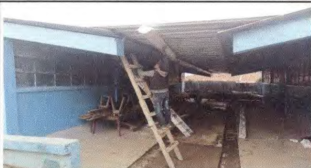
Foto 7: Instalación de canal PVC, entre las aulas del modulo 2
