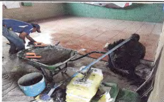
Foto 4: Colocación de piso ceramico del aula de Párvulos 3
