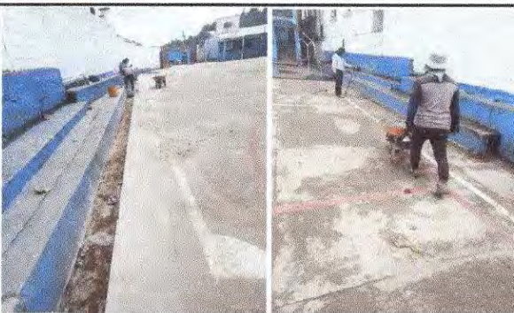
Foto 9: Proceso de repación de cuneta de concreto en la cancha de baloncesto.
