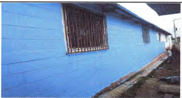
Foto 11: Proceso de pintado de paredes de aulas exteriores.
