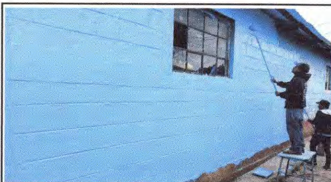
Foto 10: Trabajadores realizando la pintada de paredes de aulas exteriores
