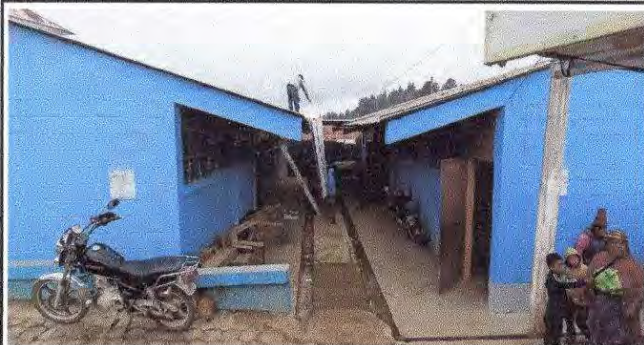
Foto 1: Colocación del techo entre las dos aulas del modulo 2
