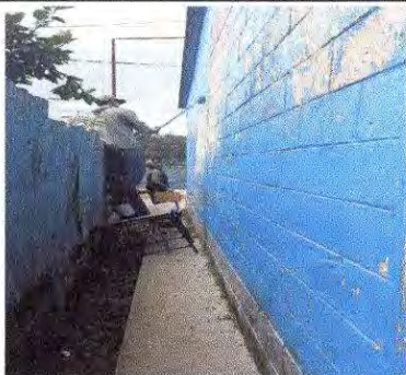
Foto 13: Proceso de pintado de paredes de aulas exteriores del modulo 2
