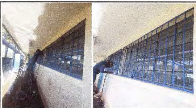
Foto 15: Herrero colocando balcones de metal a 6 ventanas del Módulo 3
